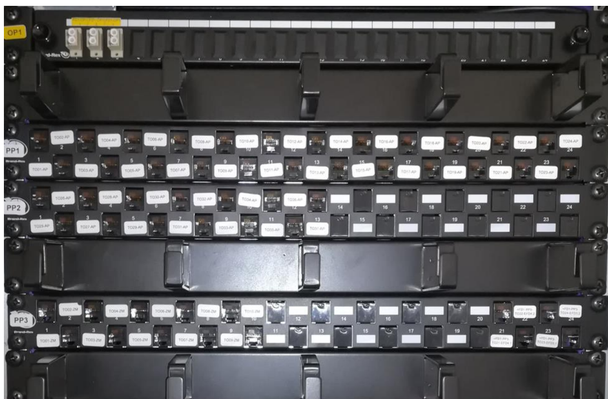
Slika 9: Primjer označavanja razdjelnika i panela
